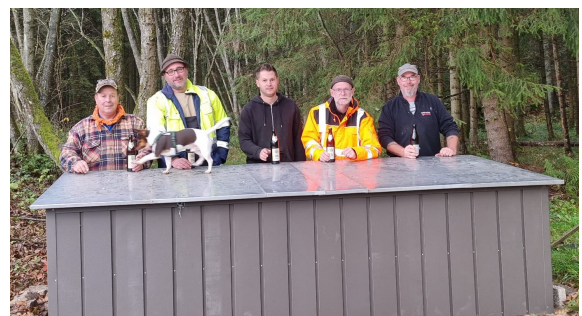
Eine schucke Gerätekiste wurde am Tennhöfle installiert
