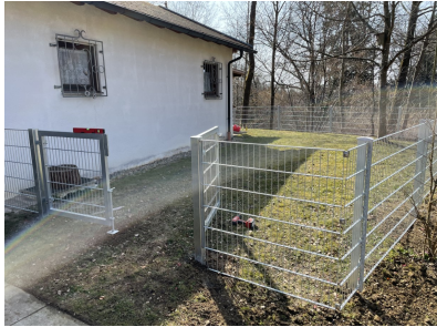
Um die Fischerklause wurde ein neuer Zaun installiert
